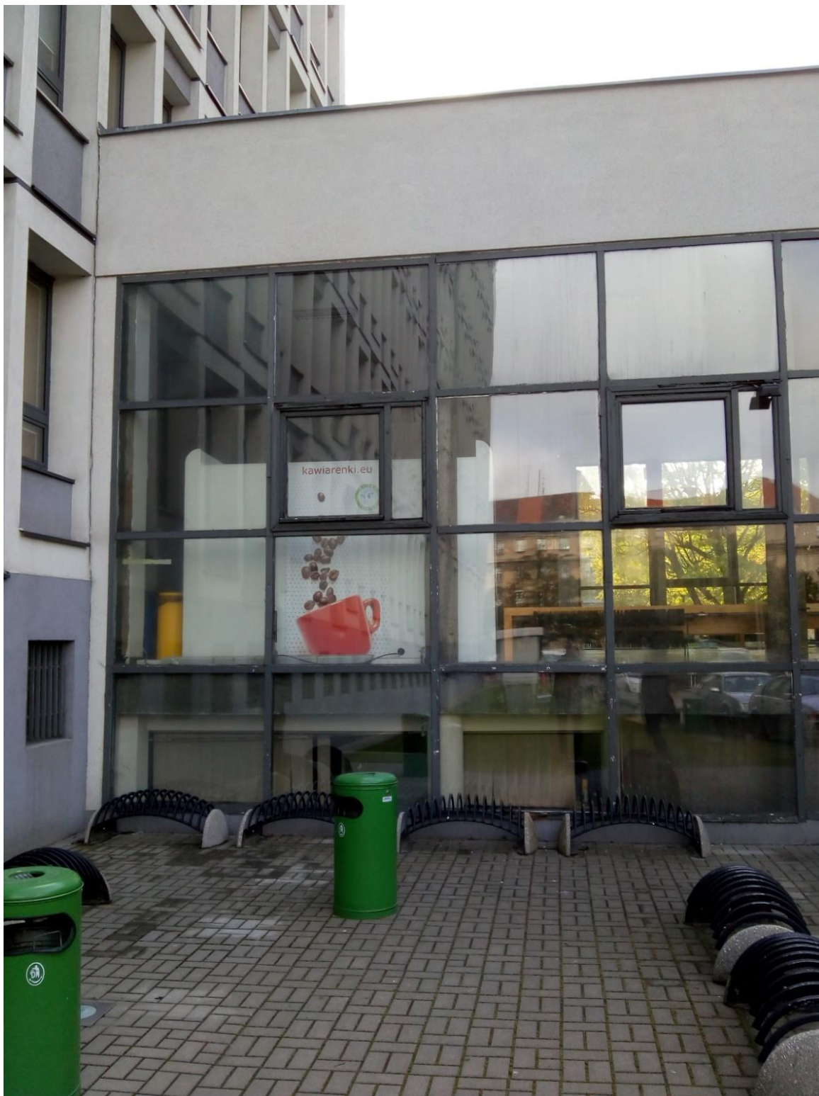
Hall główny – miejsce lokalizacji wejścia do dźwigu – przeszklenie fasadowej do wymiany na odcinku ok. 4,0m
