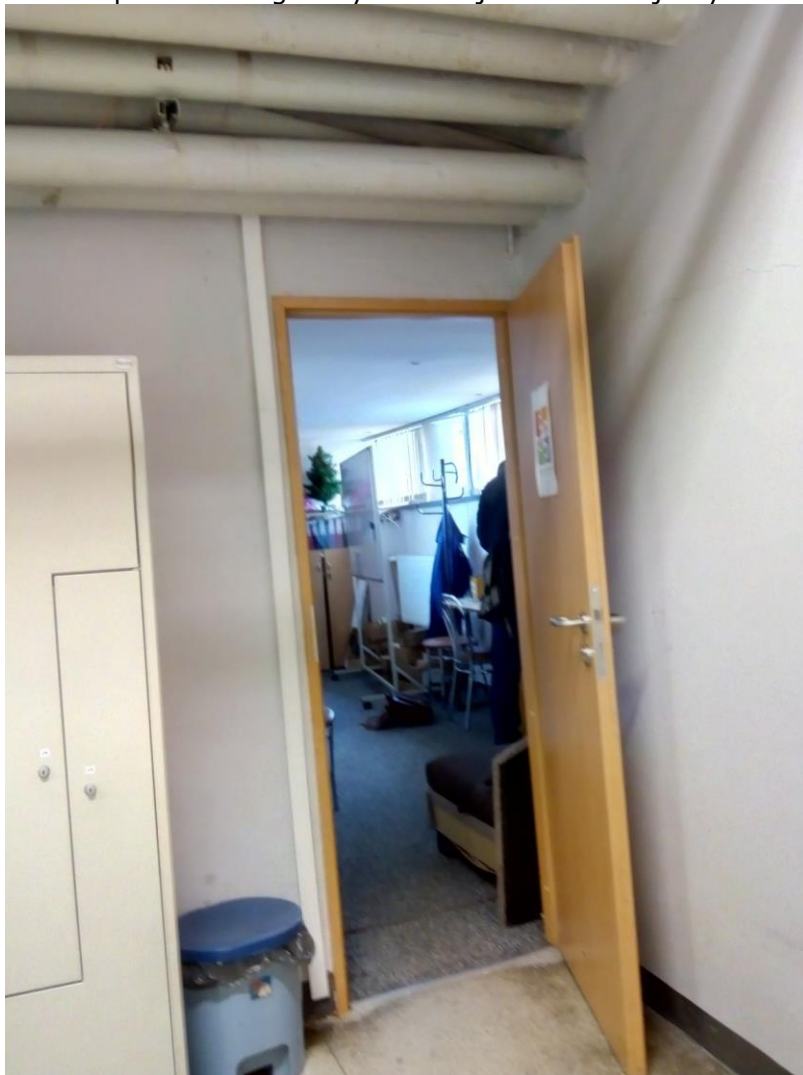
Piwnica pod hallem głównym drzwi do pomieszczenia, w miejscu lokalizacji projektowanego dźwigu. (drzwi do wymiany na nowe o odporności ogniowej)
